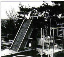
② ベルト走行式自動除塵機 (ファイヤーベルト方式)
