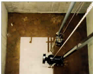
槽 取付け現場
