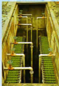
農村集落排水施工例
