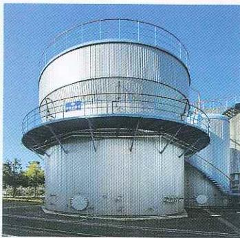
BOD=500mg/l程度の低濃度排水に適した嫌気処理システムです。
