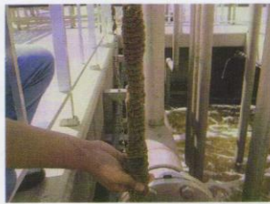
浸出水處理設施 氧化槽污泥附着狀況
