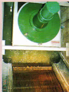
流出側からみた所
