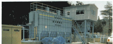
▲ 100t/h 水処理装置・他ケーキ貯留ホッパー型
