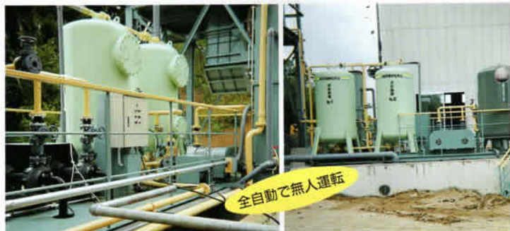
▲据付された濾過塔全影
