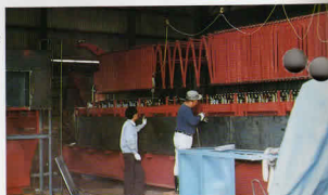
▲組立作業中のニュージャンボ脱水機
