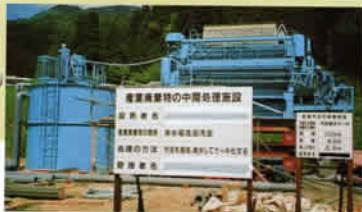
浄水場沈殿汚泥 脱水機据付中の プラント
