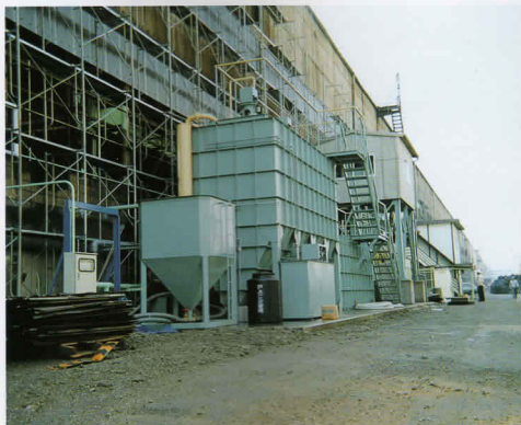
マス型シクナー式廃水処理施設
